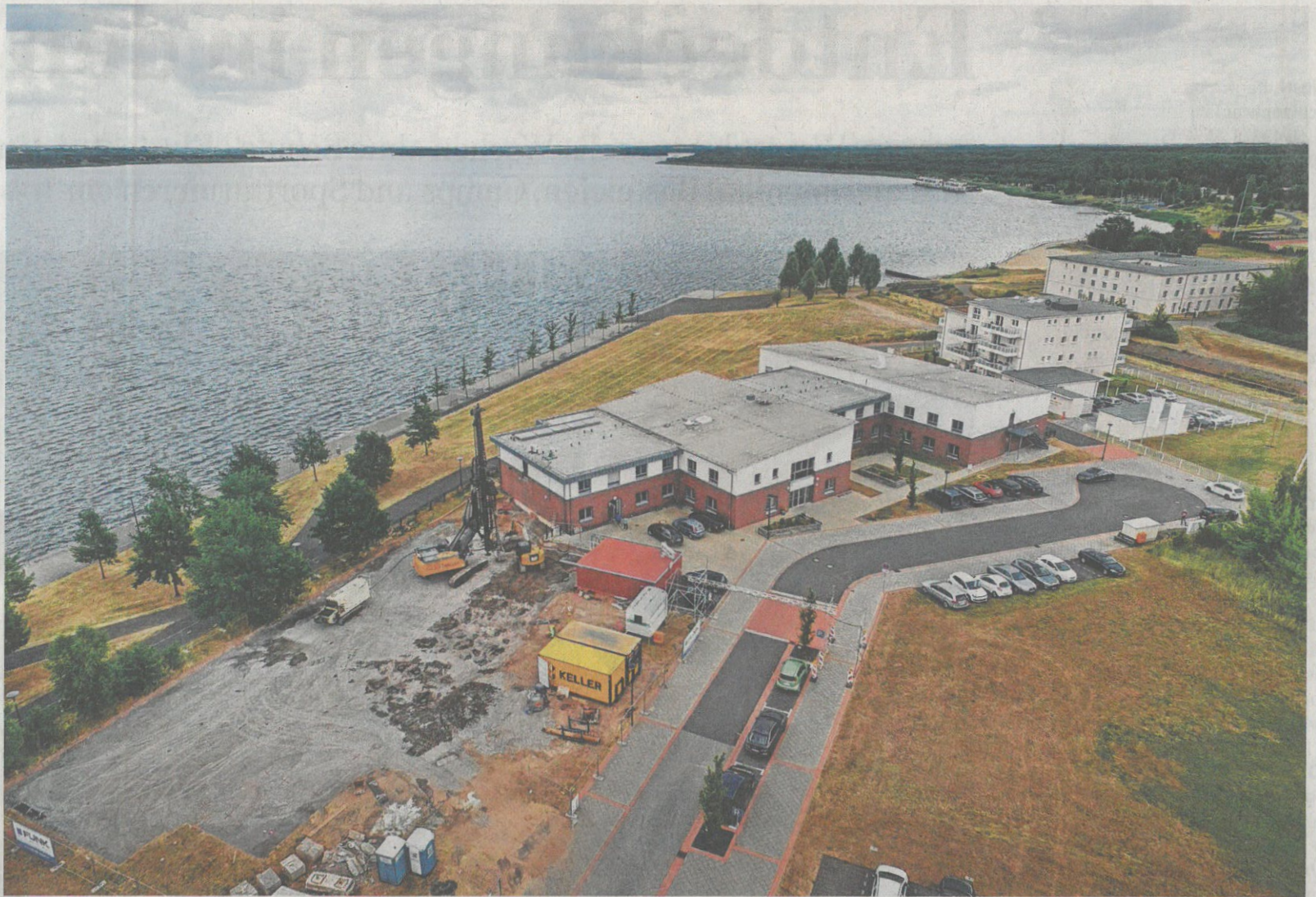
Neben dem Altenpflegeheim „Haus Am Leineufer“ wird bis Mitte nächsten Jahres ein Anbau errichtet.
