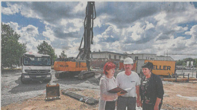
Planerin Susette Schwantge, Bauleiter Wolfgang Jahn und Heim-Chefin Julia Stein (v.l.) sprechen über den neuen Anbau.
